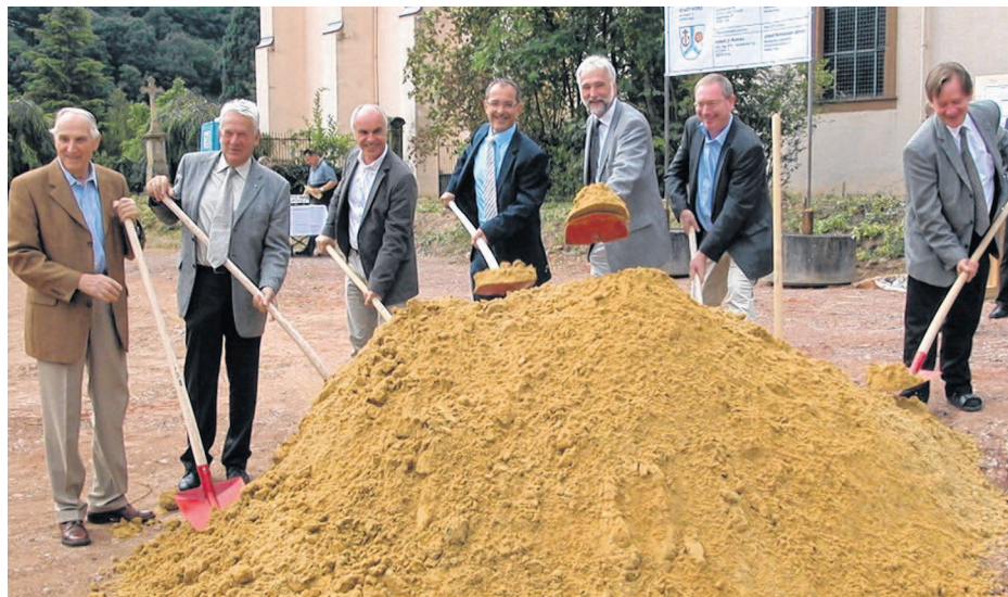
Beim offiziellen Spatenstich wurde Bürgermeister Karl-Heinz Frieden (3. v. re.) tatkräftig von (1. bis 4. v. li.) Statiker Albert Rohles, dem Kreisbeigeordneten Walter Reis, Architekt Gerd Kintzinger, dem 1. VG-Beigeordneten Joachim Weber, sowie (1. und 2. v. re.) Pastor Georg Dehn und CDU-Stadtratsmitglied Bernd Henter unterstützt. FOTO: MOHSMANN
